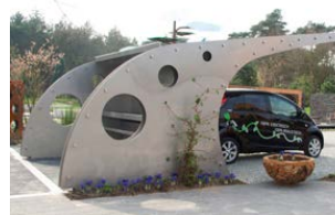
Duurzame energie biedt allerlei kansen voor decentrale opwekking (wind of zon), bijvoorbeeld met een solar carport bij het bedrijfspand.
